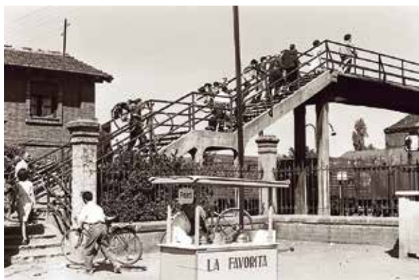
La pasarela sobre el ferrocarril se inaugura en 1927 (AHPP. Colección Fernando Foto).
