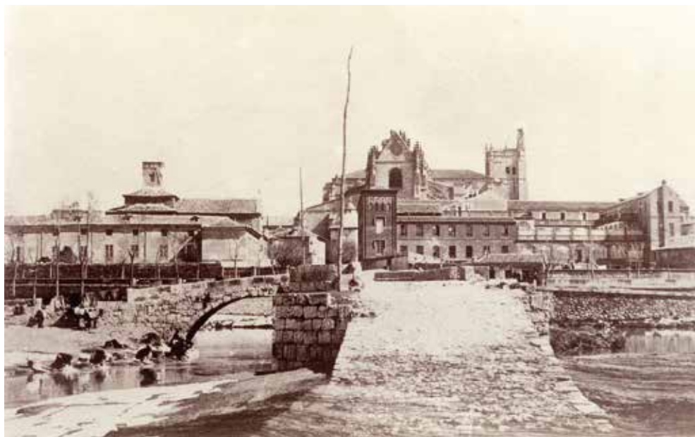
La Escuela Normal Elemental y Superior de Maestros y la Escuela Práctica se ubican en el edificio del Instituto Viejo (antiguo convento de San Buenaventura), a orillas del río Carrión (AHPP).
