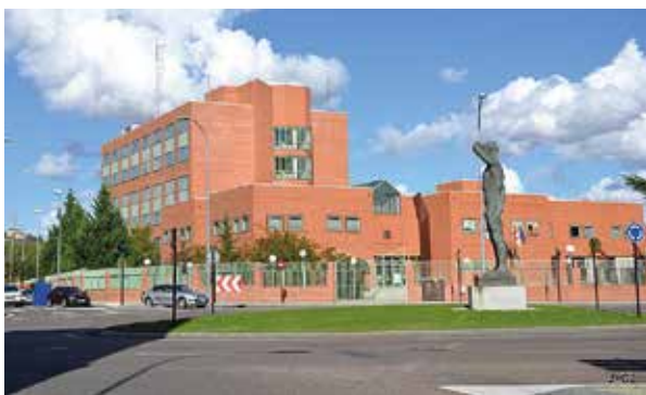
Edificio de Usos Múltiples de la Administración General del Estado (1992). (Colección José Cruz Crespo).
